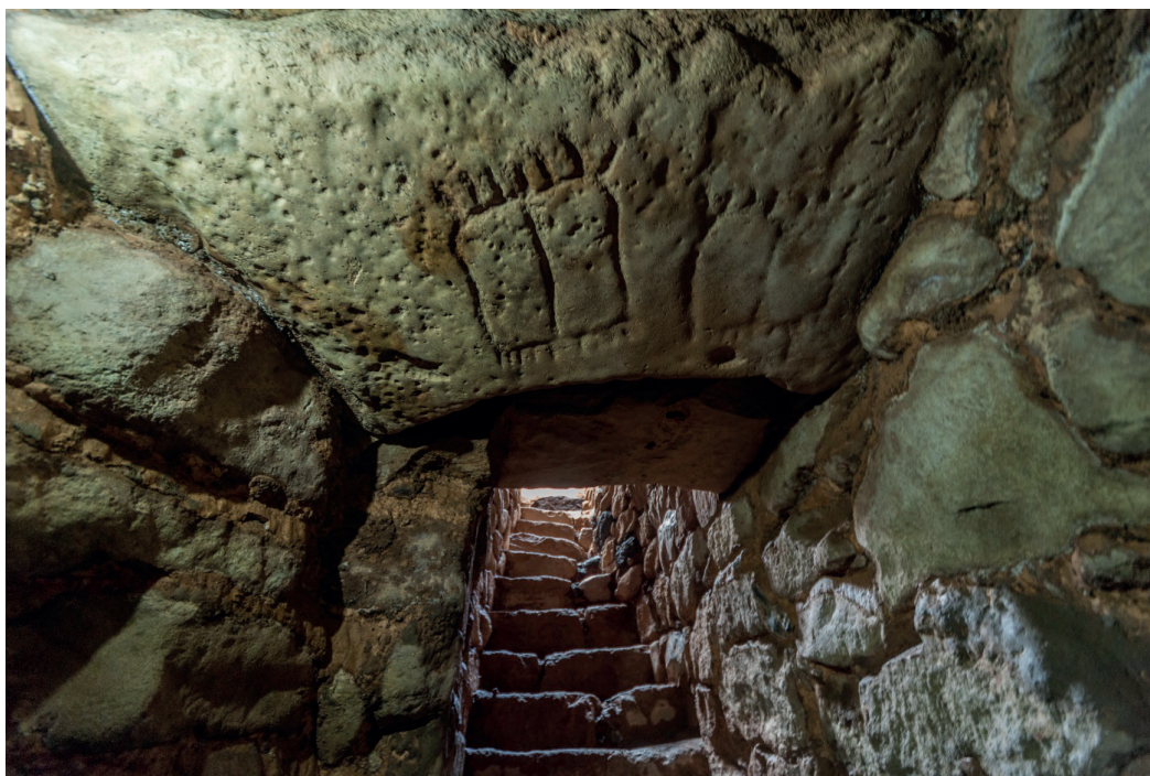
Figura 31. Ubicación del dintel con los podomorfos, integrado en la estructura constructiva del Pozo de la Cruz
