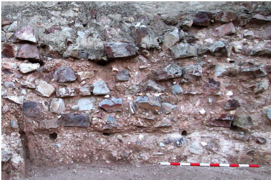
Figura 12. Detalle de junta entre cajones en L-19. Se observan disposiciones superiores e inferiores de los agujales en la junta de unión entre filas de cajones
