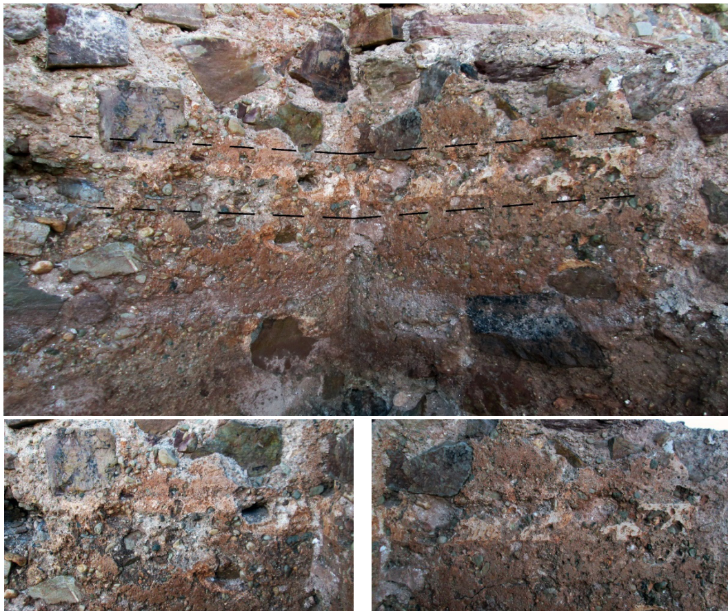
Figura 15. Documentación de la banda de estuco que definiría el posible falso despiece de sillares exterior. Línea de 10 cm de altura conservada en la esquina que conforma L20 y T20
