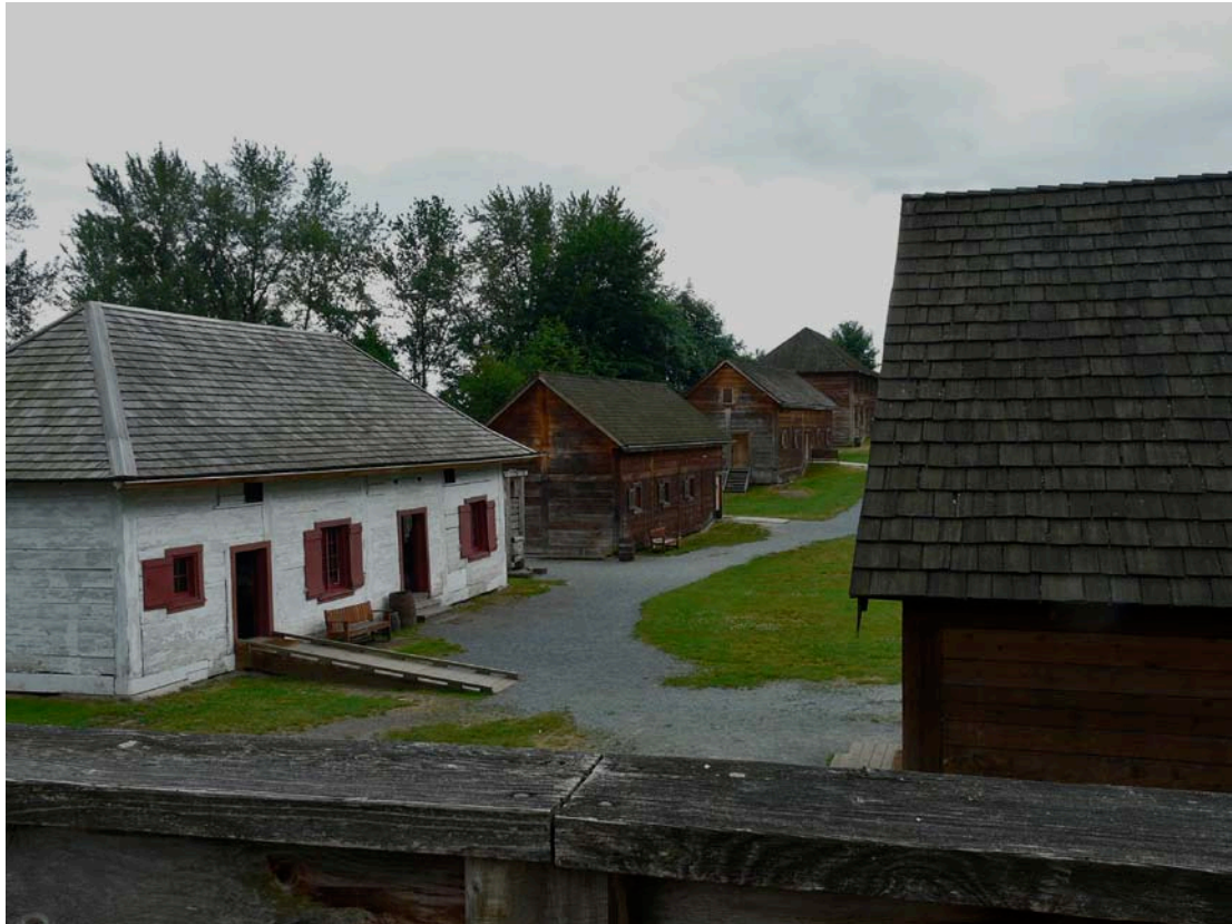
Figura 3. Sitio histórico de Fort Langley. El original fue construido por la compañía de la Bahía de Hudson en este lugar en 1939. Es el lugar donde se proclamó en 1858 la Colonia de British Columbia. La reproducción se construyó para la visita turística.
